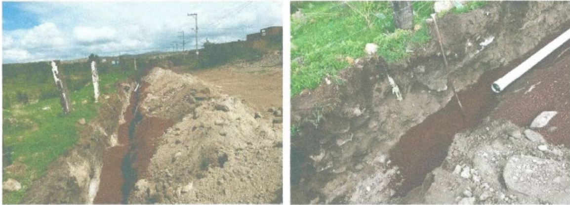
Plantilla apisonada al 85% proctor en zanjas con material producto de banco.
