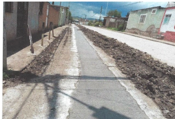
Construcción de pavimento o banqueta de concreto
