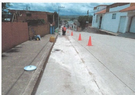
Trazo y corte de disco en pavimento hidráulico
