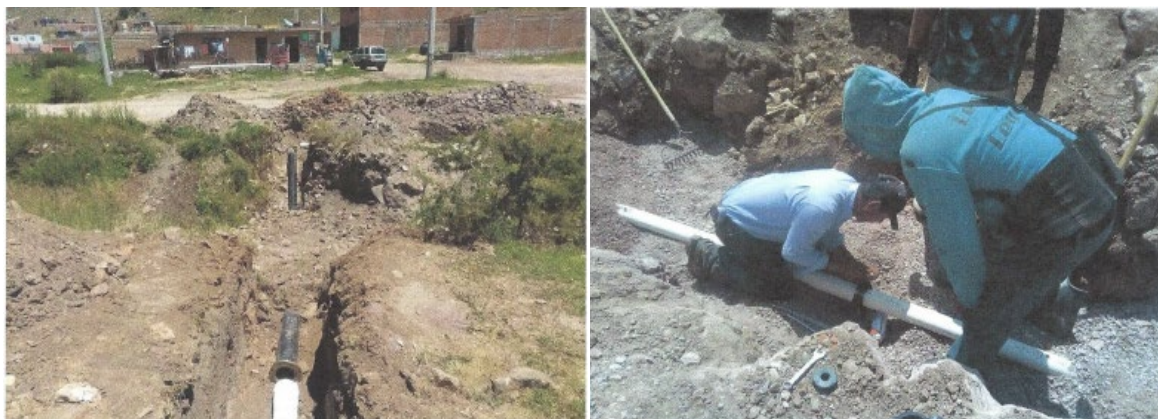
Toma domiciliaria de 0.00 a 4 metros de longitud en material "C" por método tradicional, incluye excavación para zanjas en material "C" en seco, relleno compactado al 85% con material de banco, limpieza de la zona de trabajo, instalación de la tubería de polietileno de alta densidad de 13mm.
