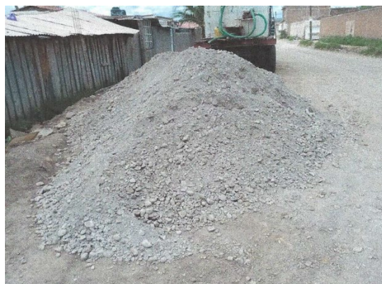
Construcción de base grava cementada
