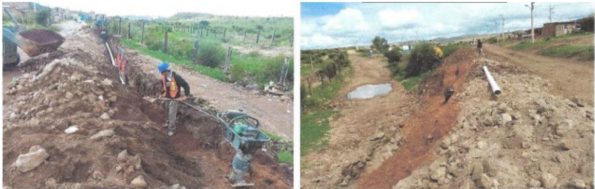
Relleno en zanjas compactado al 90% proctor, con material de banco
