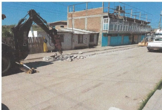
Ruptura y demolición de pavimento hidráulico
